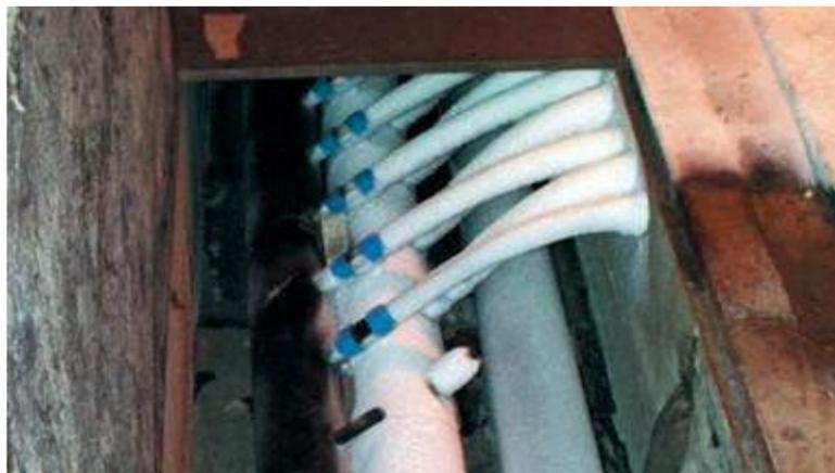
Conexión de tuberías de plástico de la pista con la distribución y colector (aislamiento térmico).
